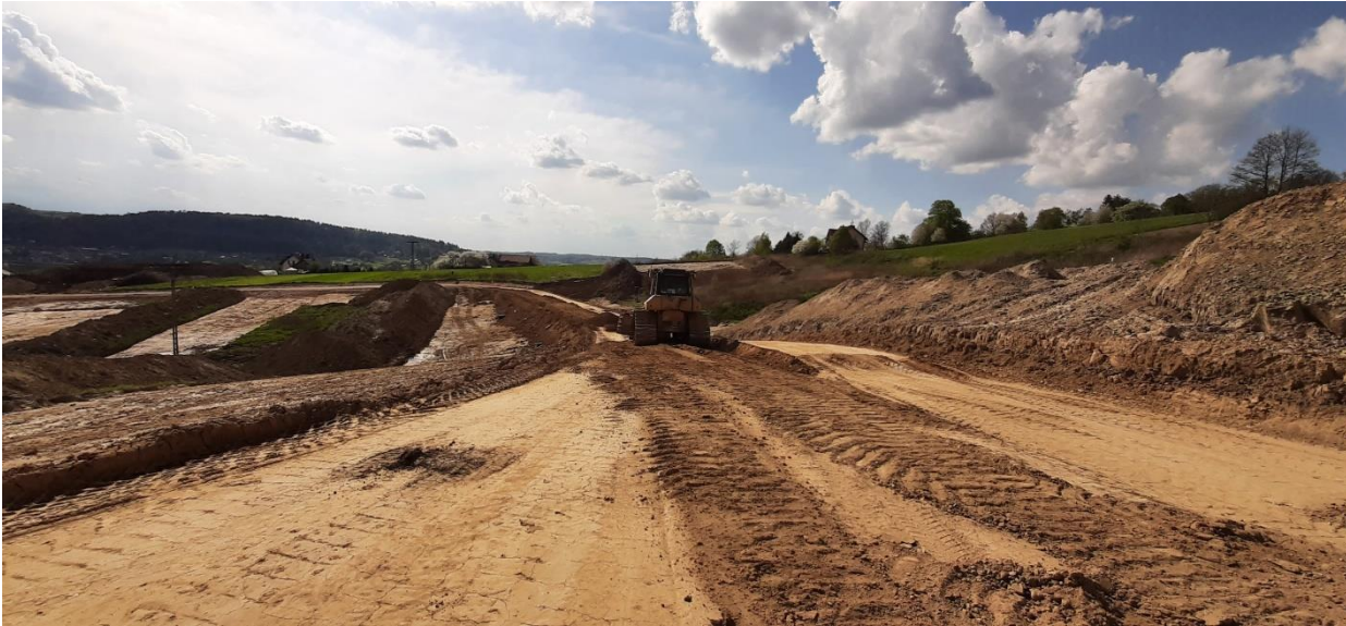
Węzeł Babica Portal Południowy - wykopy
