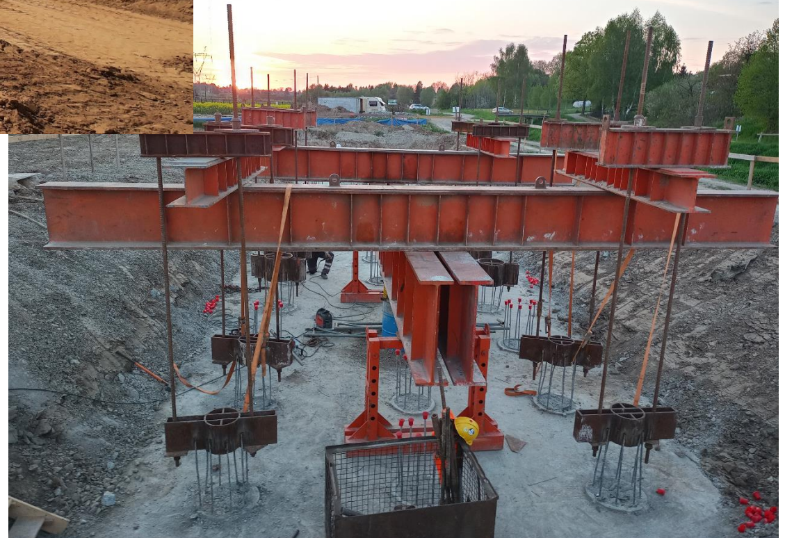
Obiekt ES-1-Stanowisko do próbnego obciążenia pali
