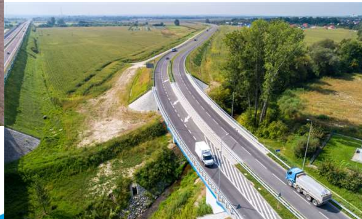
DW 869 (Iotniskowa) etap I
