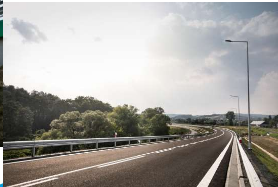
DW 988 na odcinku Babica – Zaborów wraz z budową obwodnicy Czudca
