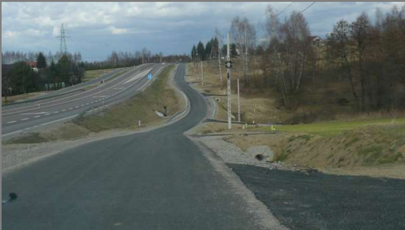
Ciąg pieszo – jezdny w miejscowości Parkosz DK 94
