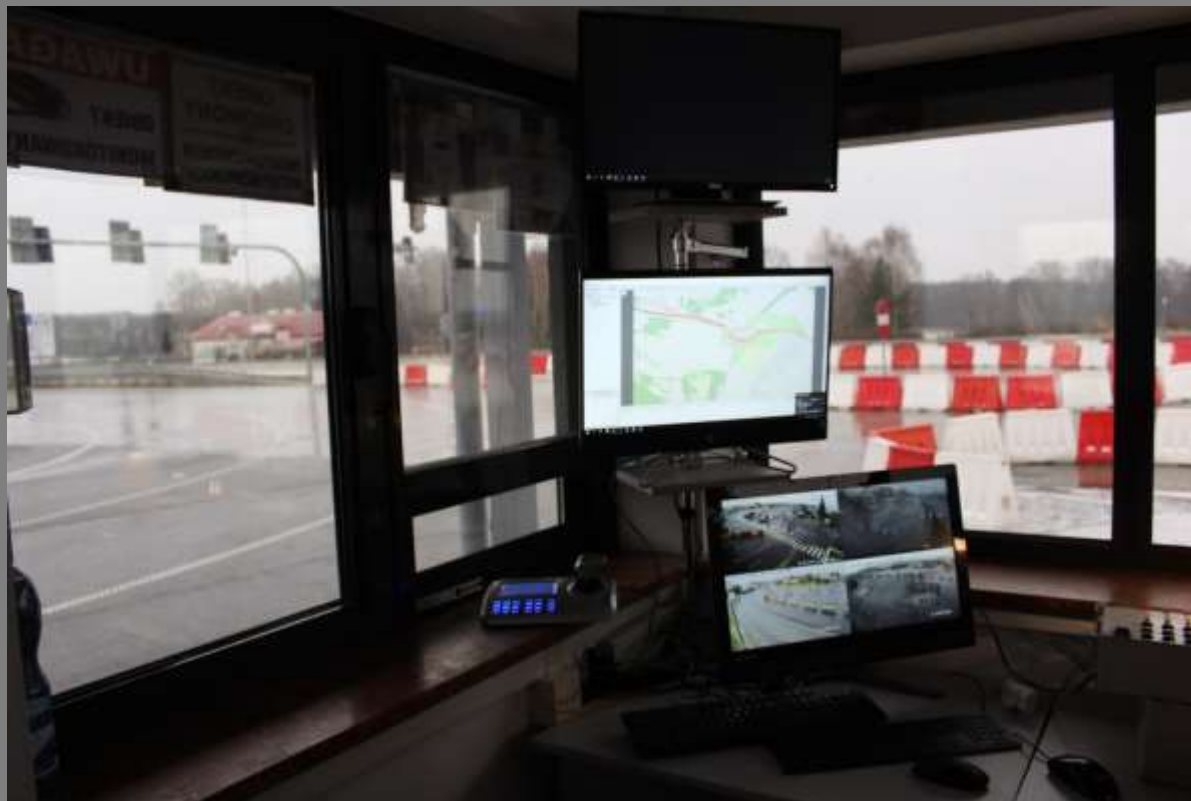
System zarządzania ruchem przed przejściem granicznym z Ukrainą w Korczowej.
