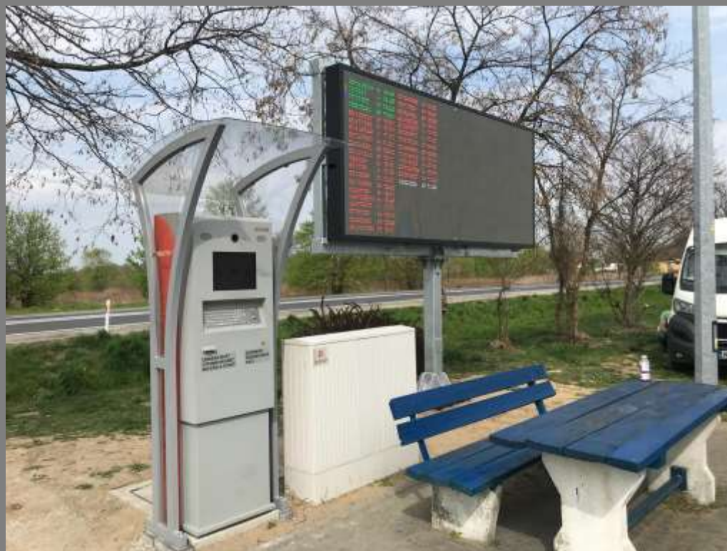
System zarządzania ruchem przed przejściem granicznym z Ukrainą w Korczowej.
