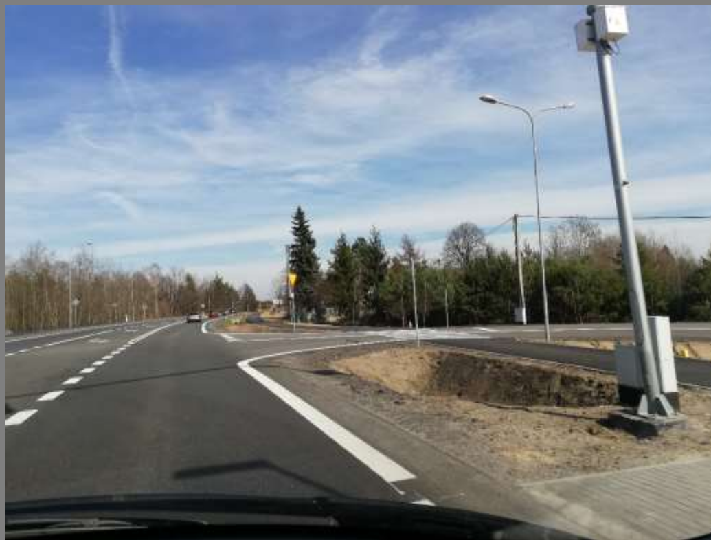
Przebudowa drogi krajowej nr 9 na odcinku Majdan Królewski - Komorów.
