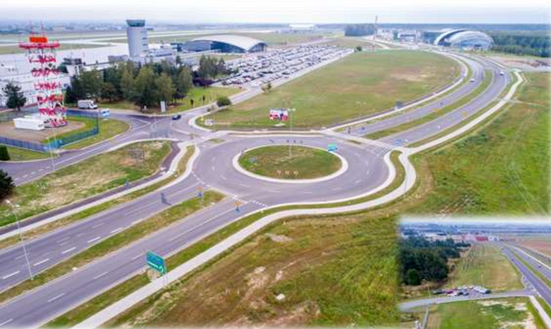
DW 869 (lotniskowa) etap III
